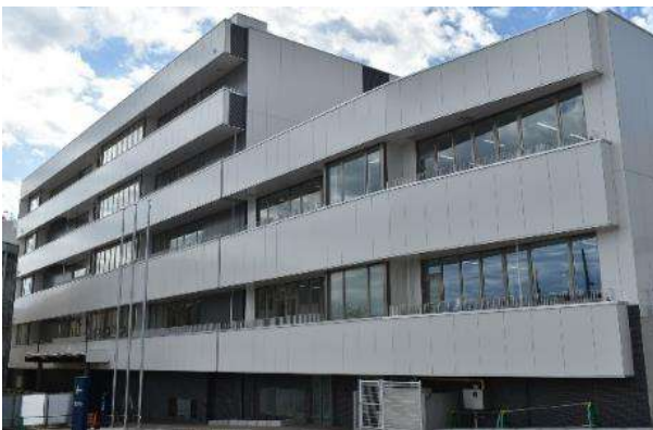
<写真1：北海道手稲養護学校三角山分校の校舎>
