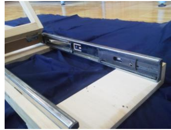
図12 スライドレール装着後の外土台
