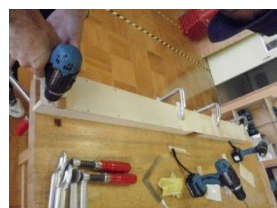
図 30 木ネジの締め付け
